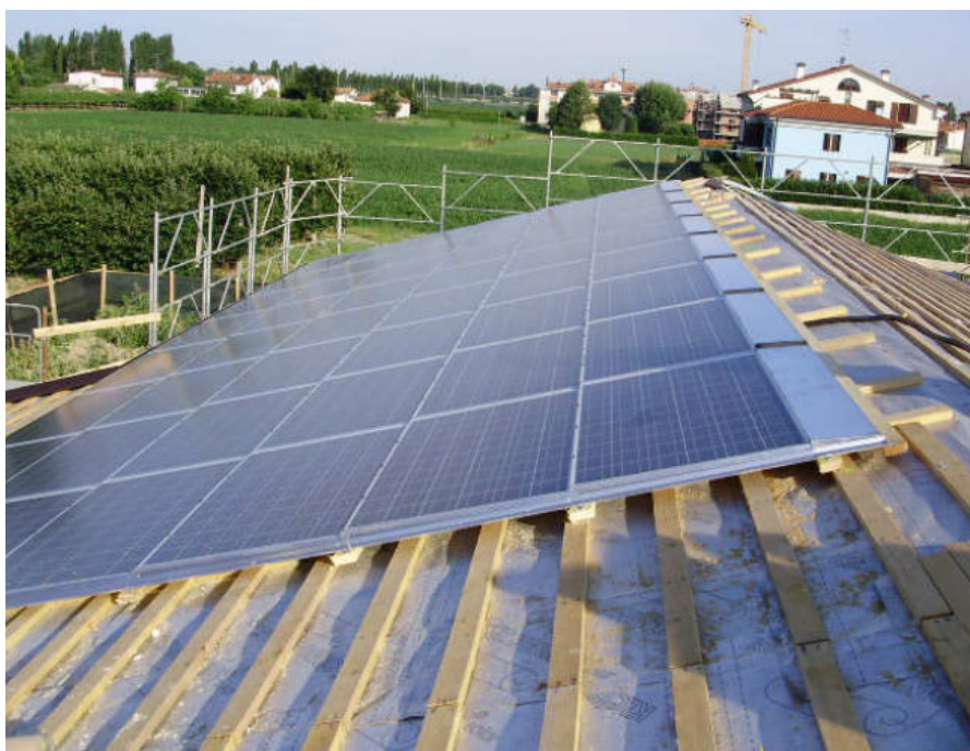
Installazione con Sistema Solrif
